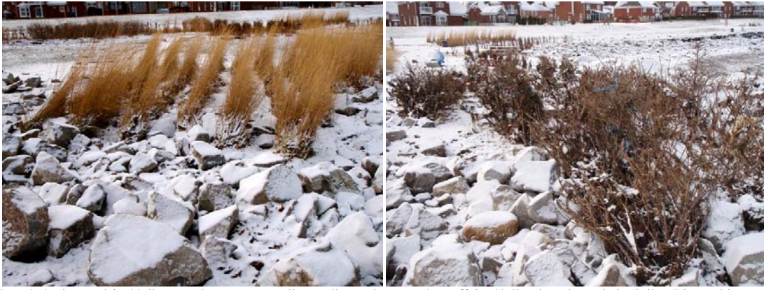
La végétation a résisté à l'assaut des vagues tandis que l'enrochement s'est affaissé à l'embouchure de la rivière Rimouski.
